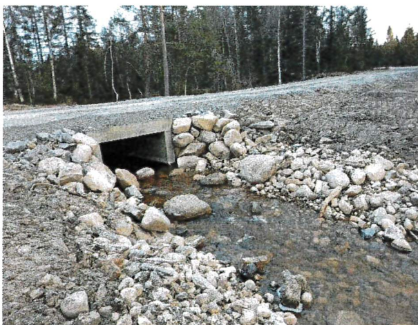
Ny dam, kulvert og bekkeløp i utløpet av Honsjøen.
