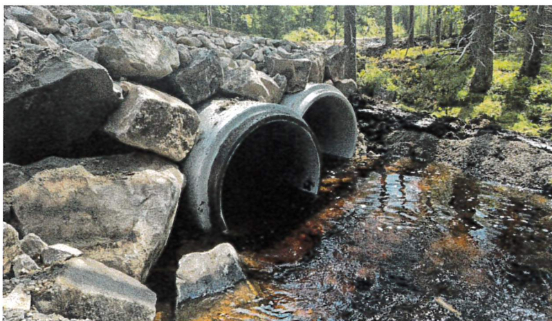
Ny kulvert der Øyungsvegen krysser Eiksbekken.
